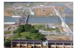
大量土の搬出のため設置されたベルトコンベヤー(陸前高田市)
