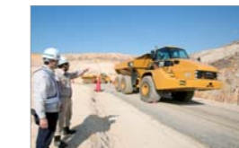
重ダンプによる造成工事(東松島市)
