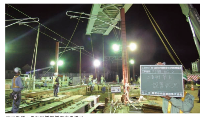
東武鉄道への仮設橋架橋工事の様子
