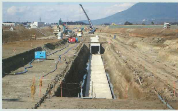
都市計画道路上野花室線の雨水管渠敷設状況
