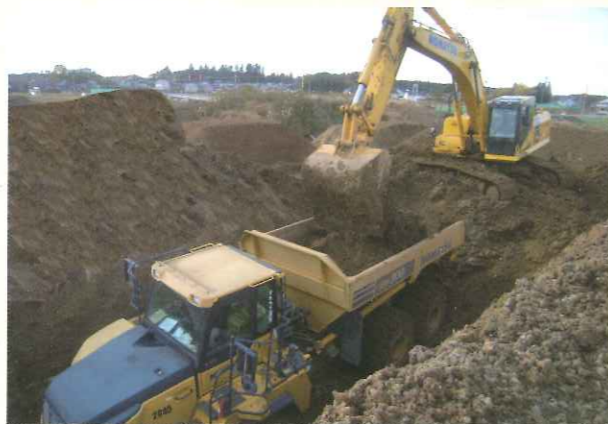
重機による施工風景
