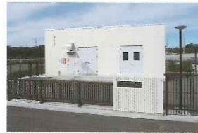
流星台中継ポンプ場
