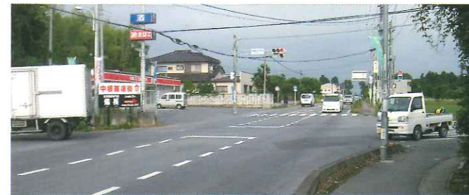
県道土浦大曾根線 柴崎十字路の改良前(左) 改良後(右)
