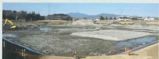
花室川調整池 造成工事
