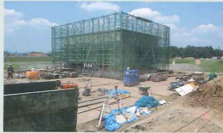
汚水中継ポンプ場の建設工事
