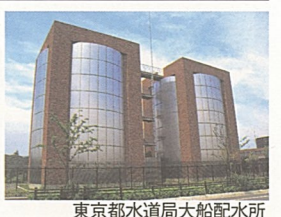
東京都水道局大船配水所
