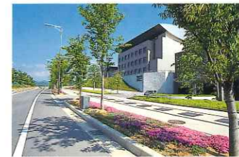
●東中央線(木津南地区)美しい景観を持つ地区のシンボル道路です。
