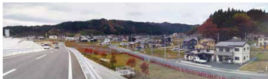
①土地区画整理事業と漁業集落防災機能強化事業を組み合わせた整備
