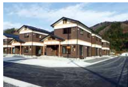
まさない 砦内町営住宅 (木造・2階・13棟・13戸・3DK、4DK)
