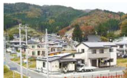
②再建が進む高上げ地・高台の住宅
