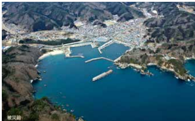
出典：いわて震災アーカイブ 提供者：岩手県県土整備部河川課/田老海岸 H22.3.9撮影
