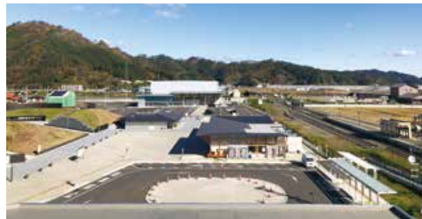
③国道沿いに立地したスーパーマーケット
