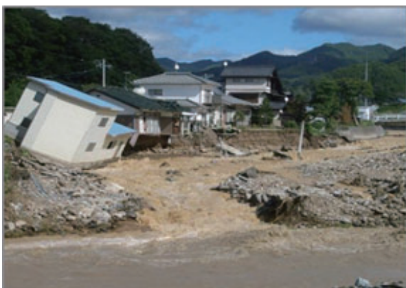
【写真1】余地川と抜井川合流地点の被災状況
