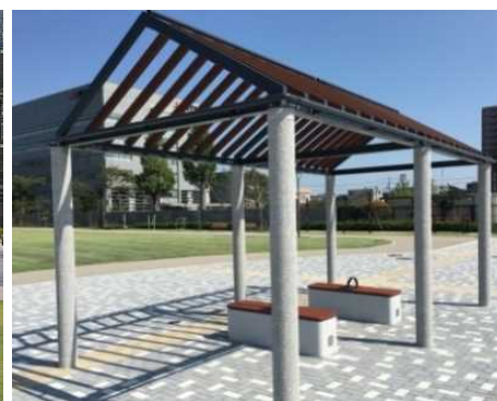
災害時には仮設テントとして利用できる防災パーゴラ
