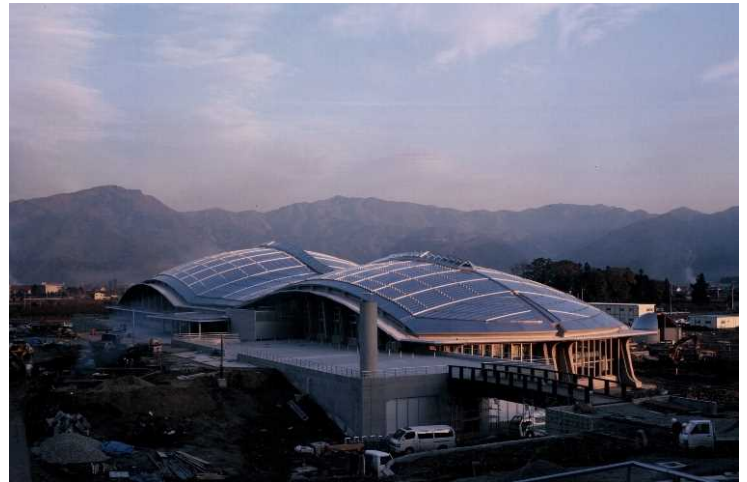
体育館・プール棟
