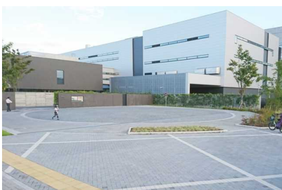
隣接する造幣局との舗装デザインの統一による一体的な景観形成
