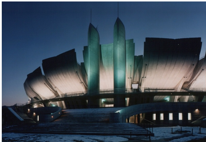
◆多目的競技場（長野オリンピックスタジアム）
