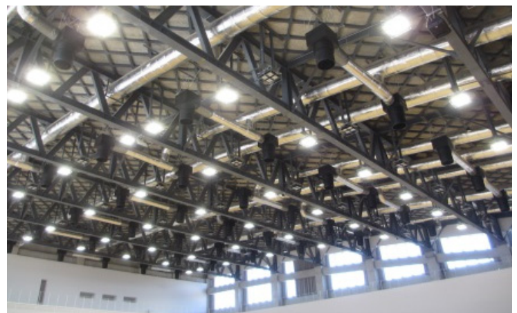
◆地震対策のため、吊天井を改修
