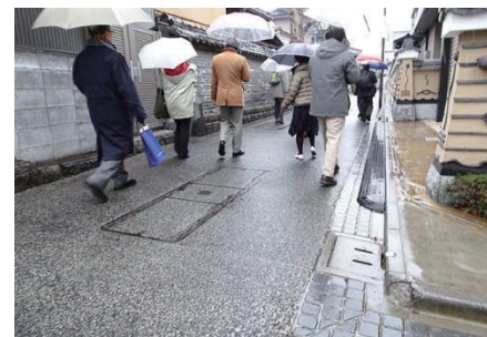
築地塀通りの電線類地中化と道路修景整備：無電柱化と石畳調の舗装が、シンボルの築地塀（練壁）や歴史的景観を美しく見せる。
