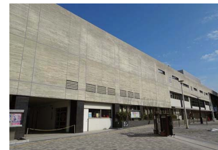
防災関連施設「谷中防災コミュニティセンター」：既存のコミュニティーセンターを建替え整備、隣接する防災広場に開放できるよう計画され、一体的に使用可能。
