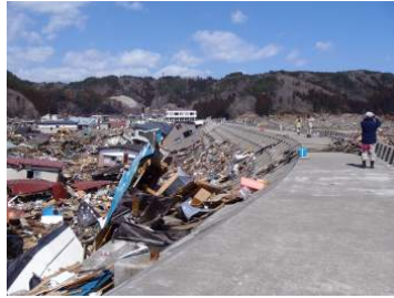
UR現地調査による被災状況写真
