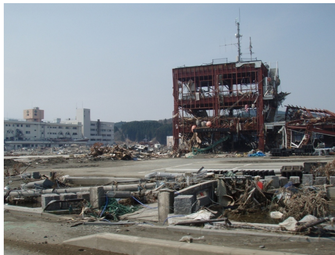
津波により骨組みだけとなった防災庁舎(宮城県南三陸町)
