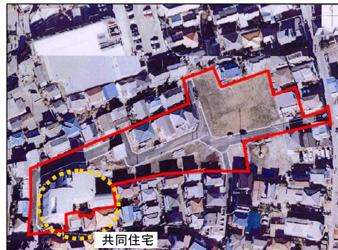
共同住宅用地、戸建再建地、土地所有者変換地等道路等が整備された。道路線形は、接道の確保、共同住宅の日影などを考慮して設定された。
