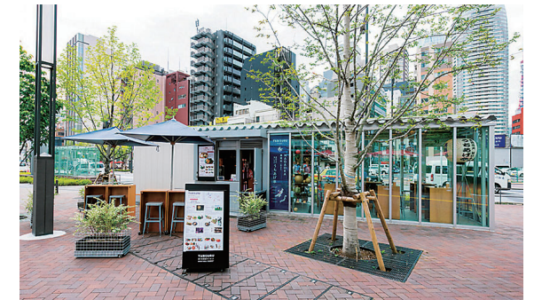
新虎通り<エリアマネジメント> 新虎通り沿いに建つ賑わい施設
