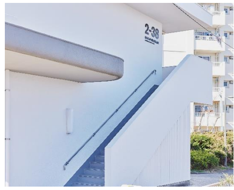
商店街施設棟の外壁
