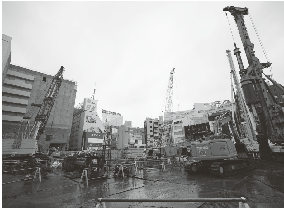
横浜駅西口に新たな息吹を吹き込むと期待される建設現場。
