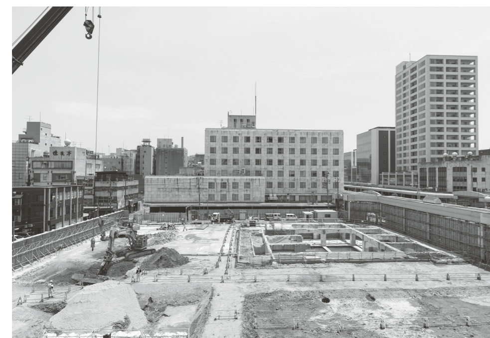
建設作業が始まったA-1及びA-2街区。中央奥の建物はリノベーションされるB街区の現・第四北越銀行。A-2街区とB街区にまたがる建物には公共施設「長岡市人づくり・学び・交流エリア（仮称）」、銀行、商工会議所が入る。
