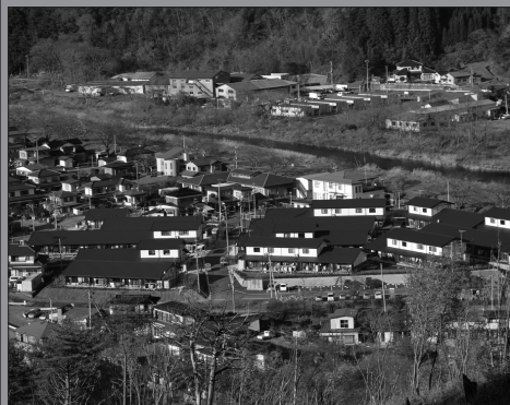
周囲と調和がとれている木造の大ケ口地区復興公営住宅
