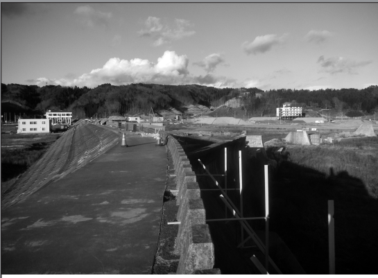
防潮堤の奥の山肌が高台の宅地が造成されている
