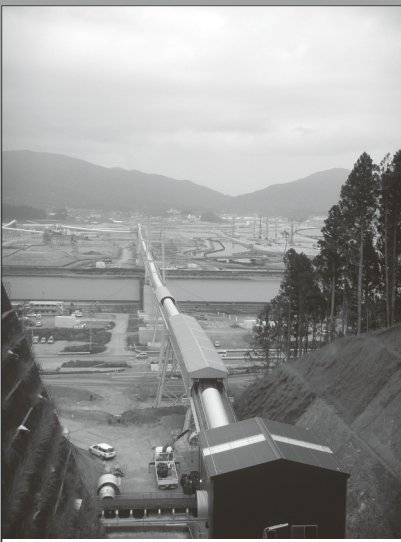
陸前高田のベルトコンベア、総延長3キロがフル稼働。
