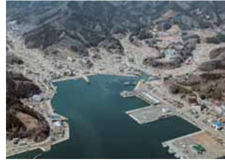
被災直後の女川町中心部(2011年4月)
