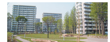
建替後の住棟
