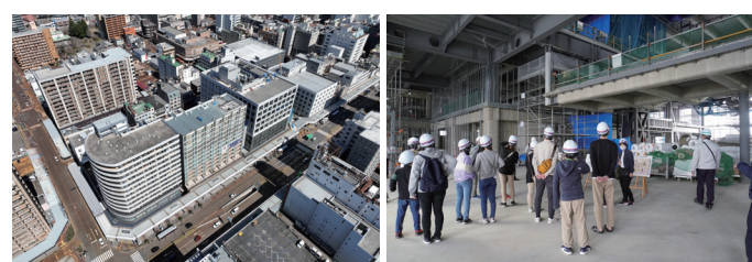
(左) 建設中の様子(令和5年3月) (右) 市内の小学生を対象に開催した親子向け工事現場見学会
