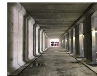
水害対応として雨水貯留槽を整備
