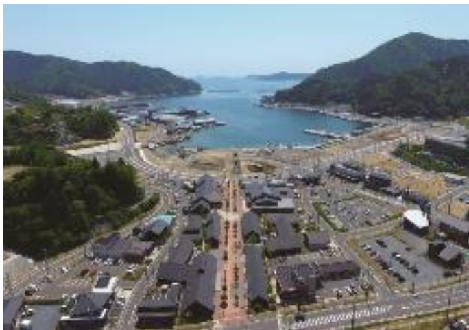
女川駅前商業エリア全景 (宮城県女川町)
